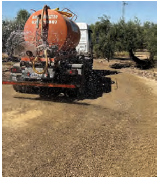
Trabajos en camino rural. AYTO.
