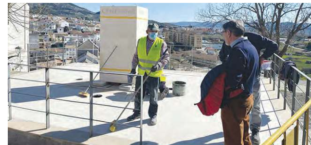
El alcalde, Valeriano Martín, supervisó las obras.
