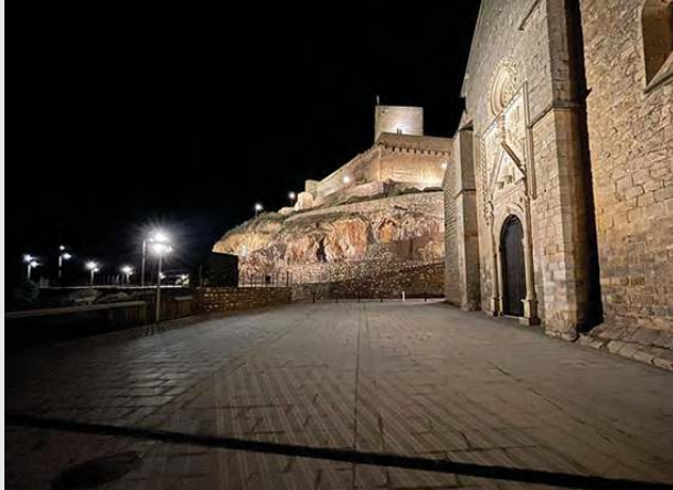
Las obras han mejorado la accesibilidad al conjunto.
