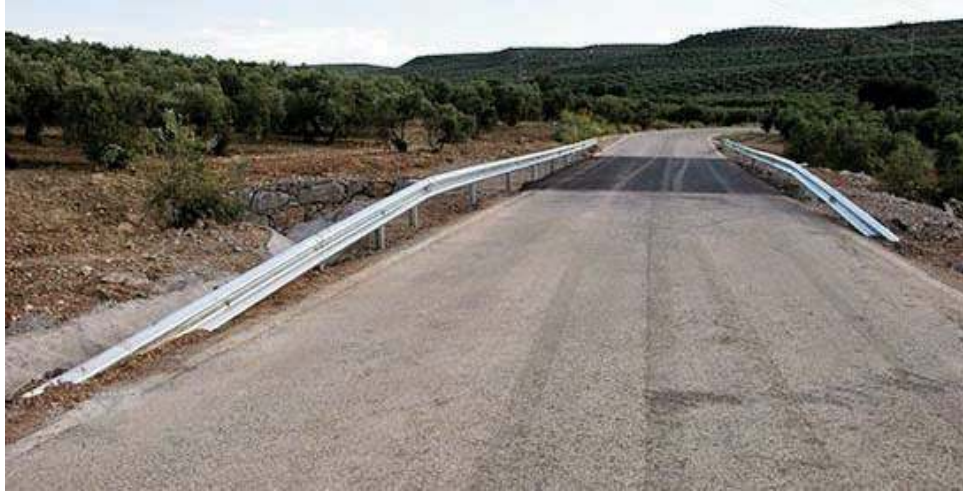
Tramo de la carretera A-6176.
