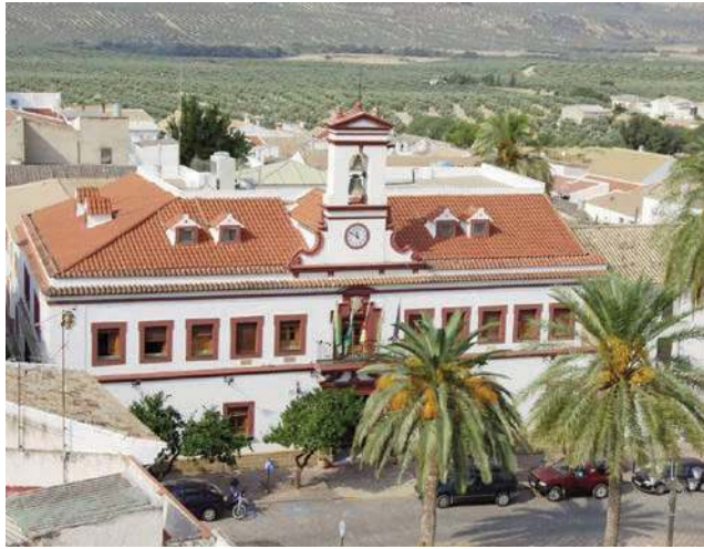
Fachada principal del Ayuntamiento de la localidad.
