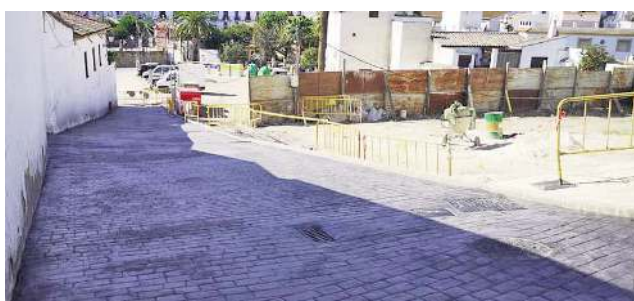
Calle Diego Muñoz Cobo tras las obras.
