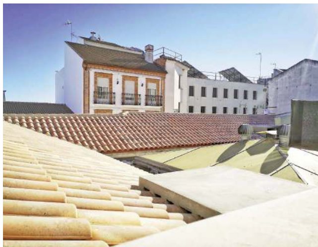
El nuevo tejado del Mercado de Abastos.
